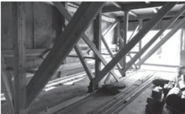
図2 施工中の補強のための仮設の柱と筋交い
