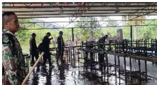
図13 細い鉄骨の小学校で水害後の災害復旧
