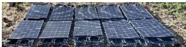
図8 パレット上に太陽光パネルを固定した簡易型発電
