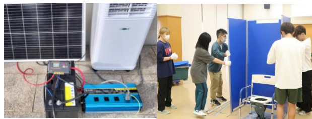
図9 格安畜発電で空調作動 図10 マンホールトイレ
